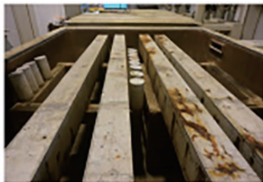
塩分により鉄筋腐食したはり
